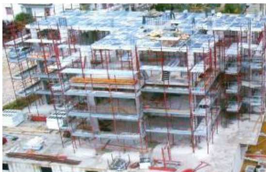
Slika 2. Fasadna skela na reprezentativnom objektu Figure 2 Scaffolds on the representative object
